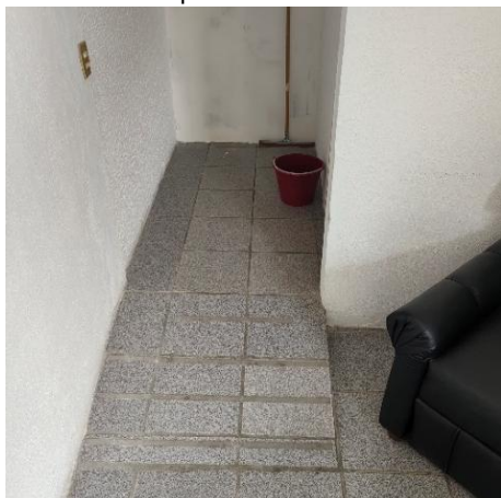
Figura 73. Rampa de ingreso al sanitario con pendiente de 8%
