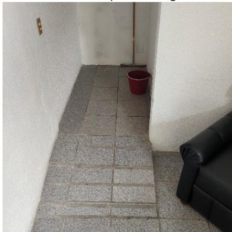
Figura 68. Rampa de acceso al sanitario, con líneas antiderrapantes desgastadas.
