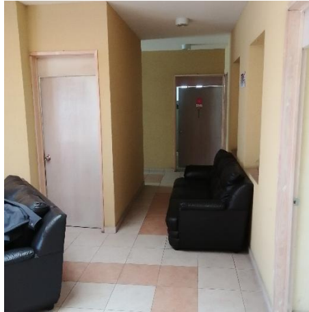
Figura 21. Pasillo a sanitarios con barrera por mobiliario.
