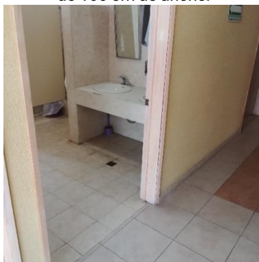
Figura 36. Acceso a sanitario, con puerta de 100 cm de ancho.
