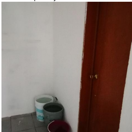
Figura 74. puerta del sanitario, con manija de pomo y ancho de 80 cm.
