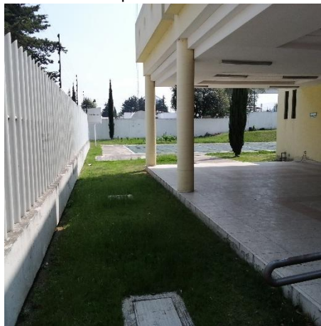
Figura 33. Zona de activación física, con piso a nivel.
