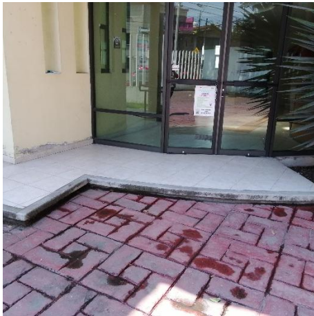
Figura 29. Escalón con peralte de 18 cm.
