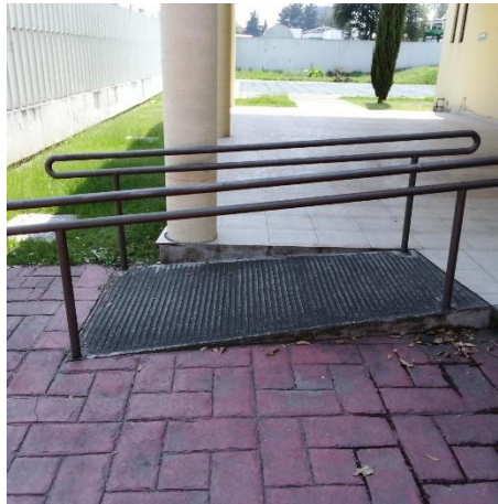
Figura 30. Rampa con pendiente de 10%
